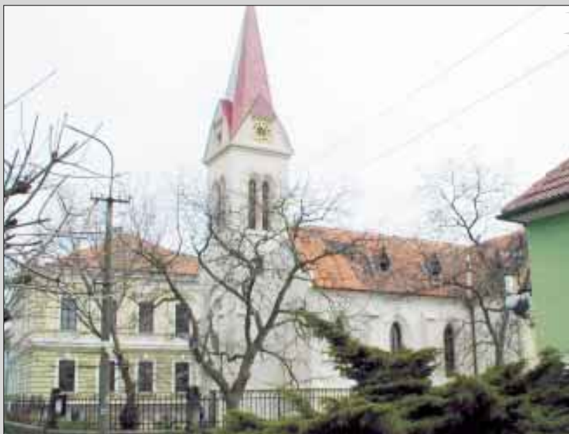
Kostel v Ročově./Die Kirche in Ročov.
